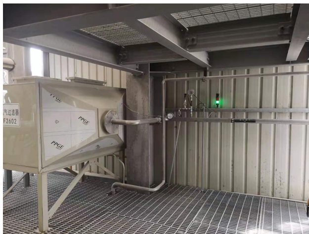
不凝气进口管道（过细，不具开口条件）
